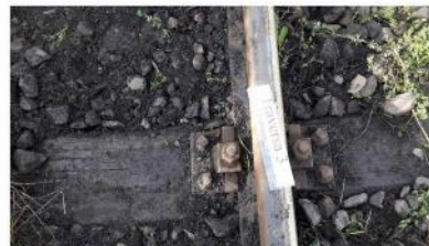
Foto nr.6 – Traversa nr. 3 (firul interior al curbei/șina din partea stângă în sens de mers)
