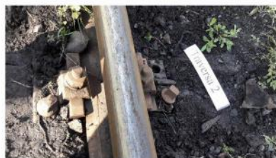
Foto nr.4 – Traversa nr. 2 (firul interior al curbei/șina din partea stângă în sens de mers)
