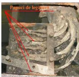
Fig.2 Papucii de legătură ai cablajului de forță de la canalul de cabluri
