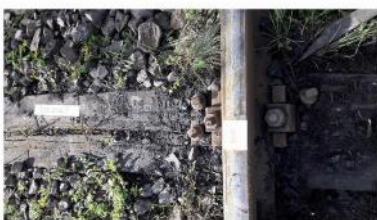
Foto nr.10 – Traversa nr. 5 (firul interior al curbei/șina din partea stângă în sens de mers)
