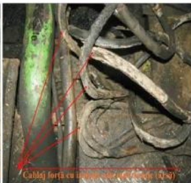
Fig.5 Cablajul de forță al MET nr.4 înainte de jugul de fixare în canalul de cabluri desfăcut
