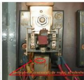
Fig.7 Releu maximal de curent poziția 54, grupa 1-4 MET
