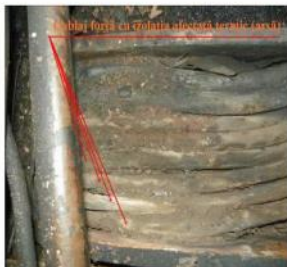
Fig.4 Cablajul de forță al MET nr.4 înainte de jugul de fixare în canalul de cabluri
