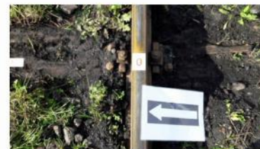
Foto nr.2 – Traversa nr. 1 (firul interior al curbei/șina din partea stângă în sens de mers)
